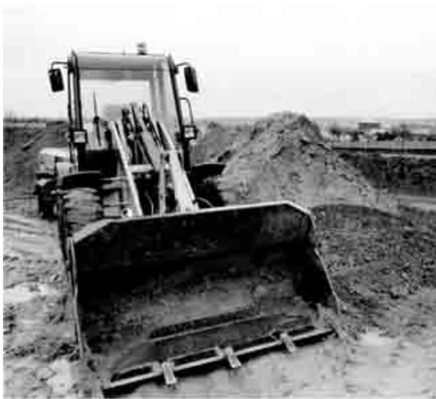
Bagger in Aktion. An dieses Bild werden die Zessinger sich in den kommenden Jahrzehnten gewöhnen müssen. (Foto: Christian Mosar)
