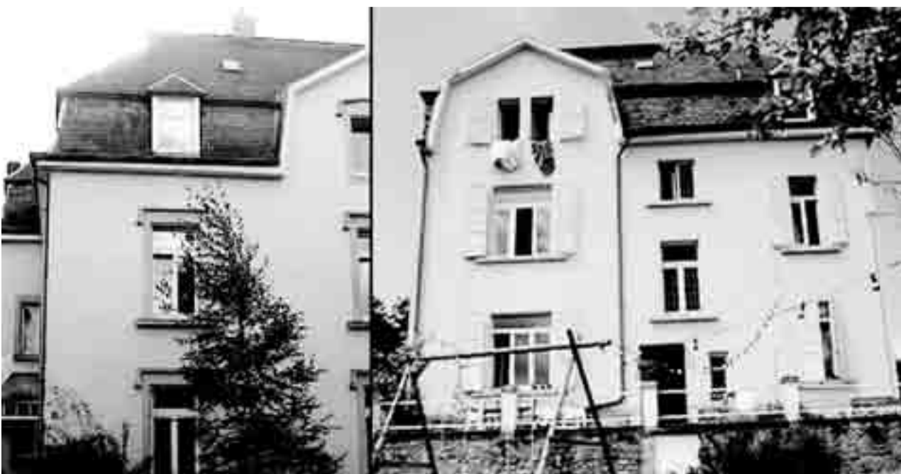
Die Nr. 112 in der Rue de Trèves auf Cents. Das Haus, das kurz nach dem 1. Weltkrieg gebaut wurde, soll nun lukrativeren Neubauten weichen.
