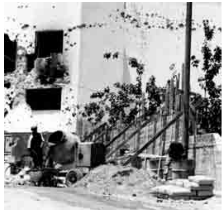
La vie continue: devant une maison à moitié détruite, un homme prépare du béton.
