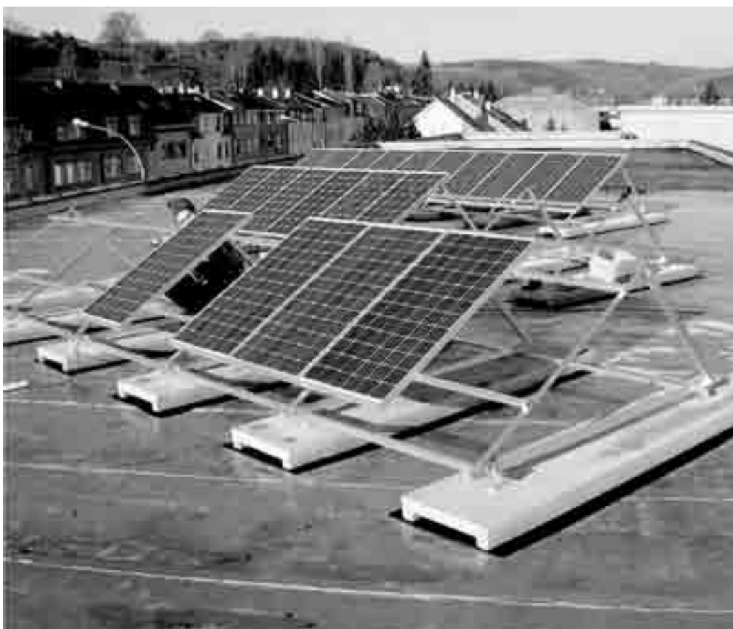
Montage der Anlage auf dem Dach des LETT.
