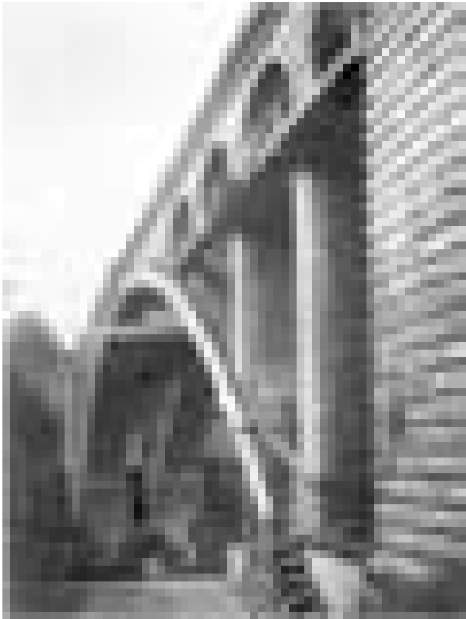
Wieviel Verkehr hält eine Steinbrücke aus? Bei der Belastungsprobe von 1933, im Beisein des 90jährigen Erbauers Paul Séjourné, waren die Ergebnisse "denkbar günstig", wie J.P. Koltz schreibt. Heute wird die Stabilität der Adolphe-Brücke in Frage gestellt. (Foto: Bern. Kutter)
