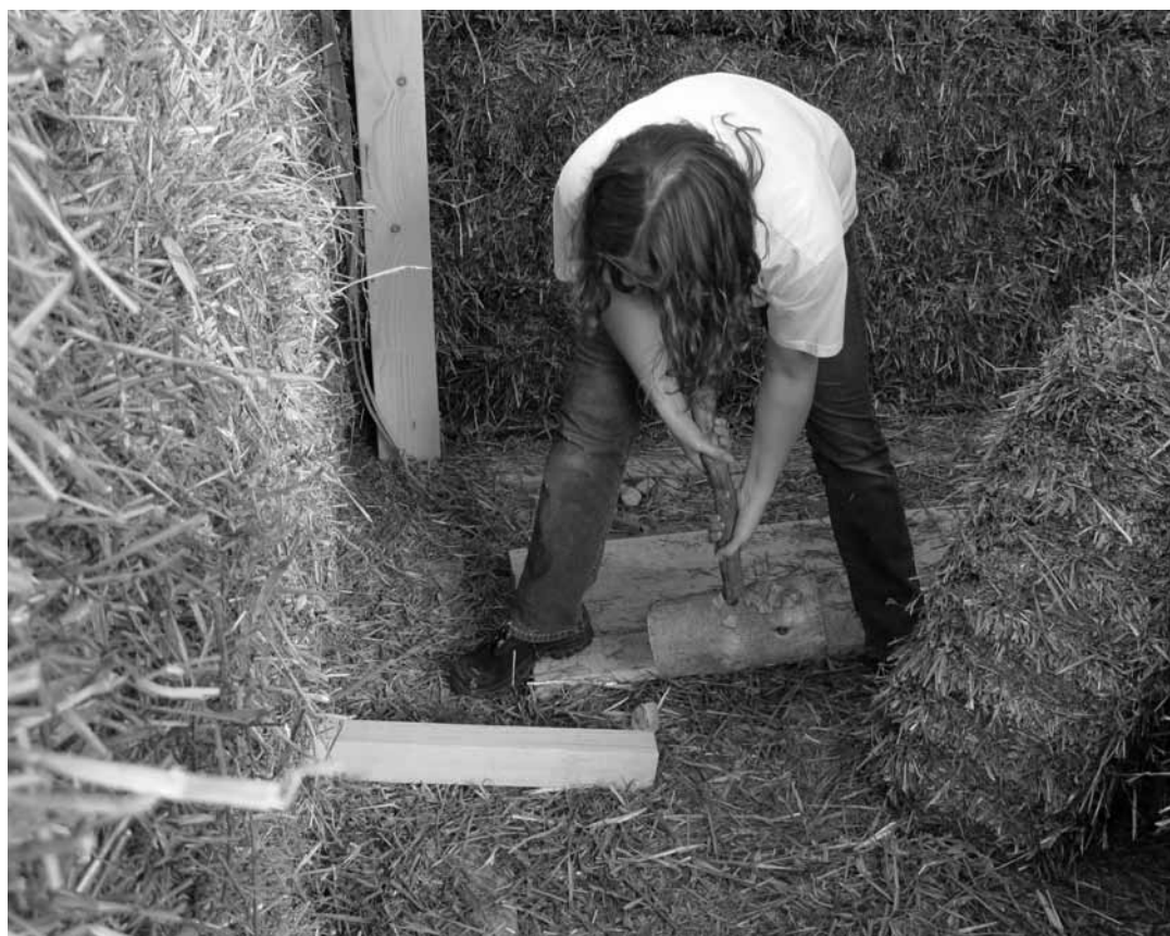
Damit die Strohballen auch wirklich ein gerades Mauerwerk bilden, braucht es genaues Maß und auch mal Körpereinsatz.
