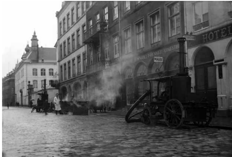
PHOTO : AUGUSTE JUNGBLUT RUE NOTRE-DAME. MACHINE À VAPEUR DESTINÉE AU NETTOYAGE DES SIPHONS (VERS 1928)
