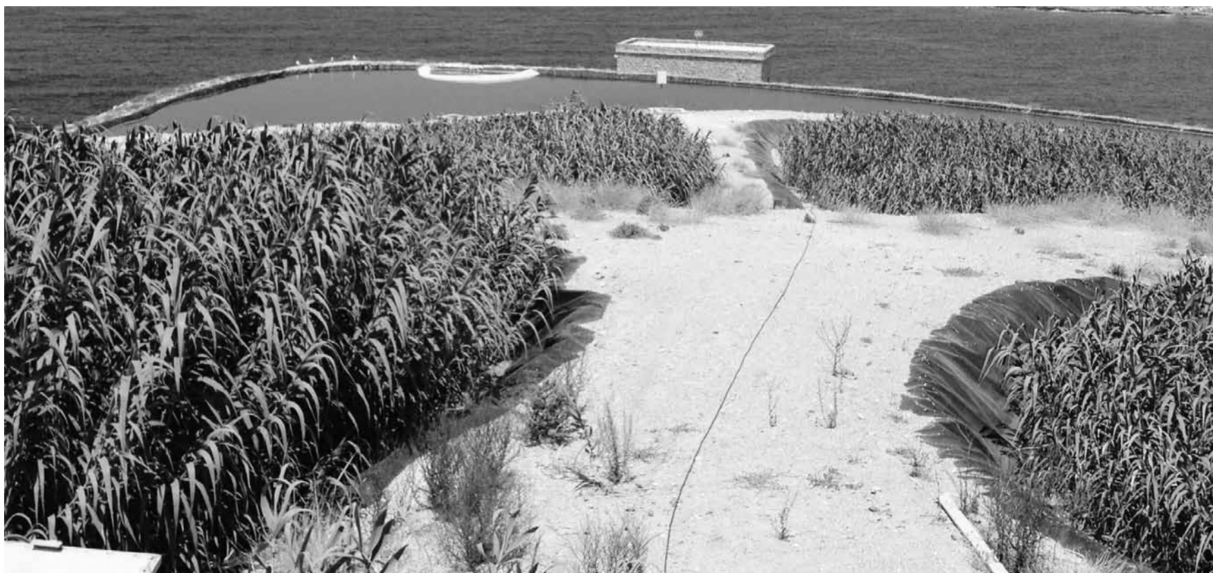
Auf der Kykladeninsel Antiparos behandeln Pflanzenkläranlagen das Abwasser.
