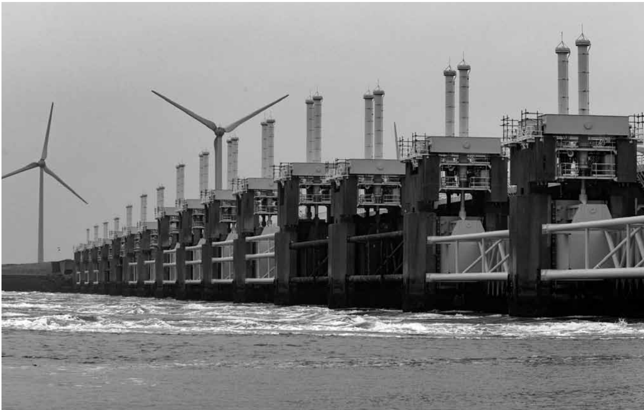
Die Lebensversicherung der südwestlichen Niederlande: Ein gigantisches Sturmflutwehr, um das Flussdelta der Oosterschelde zu regulieren und vor der Nordsee zu schützen.
