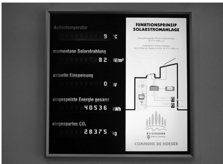
Beispielhaft ist auf dem Gemeindehaus Roeser eine Photovoltaikanlage installiert, deren Einspeisungen auch angezeigt werden.
